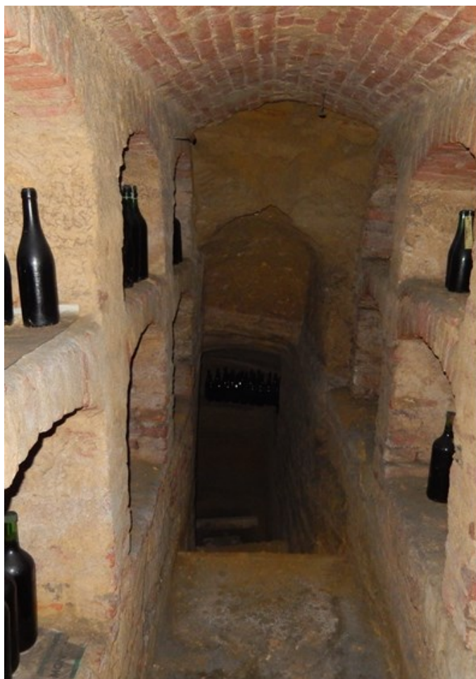
Corridoio di accesso all'infernot vista dall'ingresso
