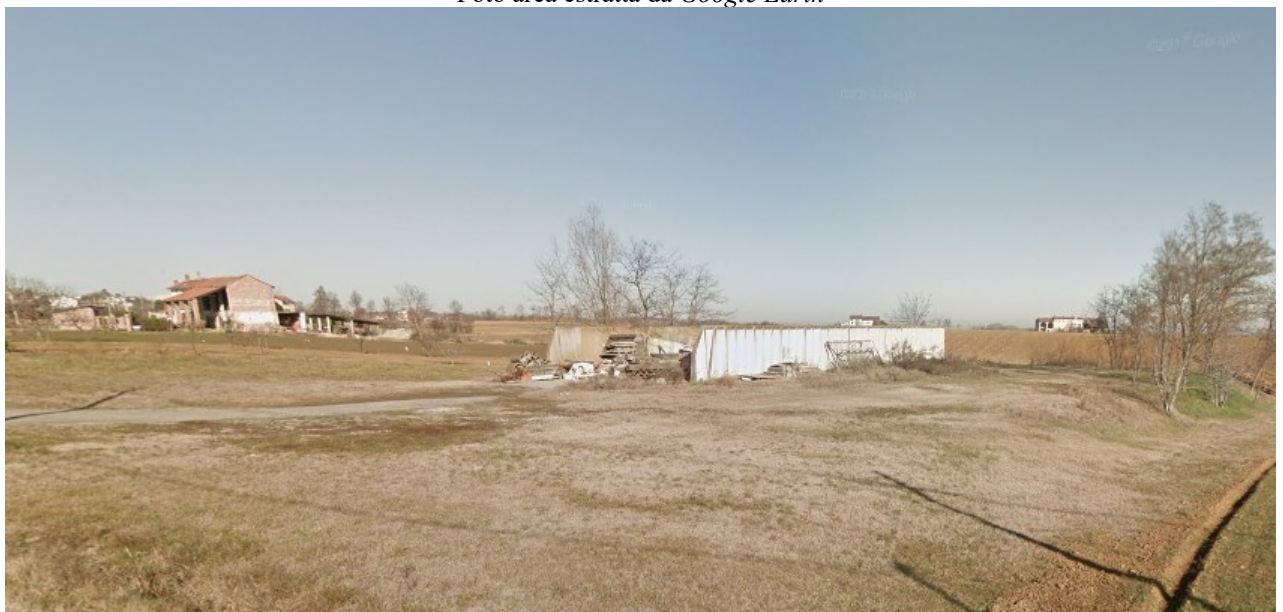
Manufatto in disuso lungo Strada Cacciolo
