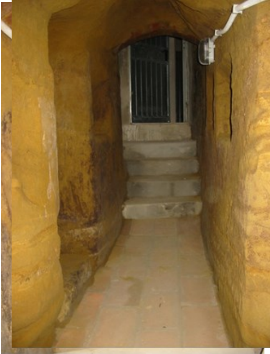
Scala di accesso all'infernot vista dall'ingresso
