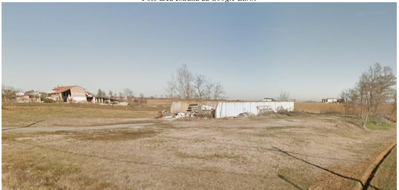
Manufatto in disuso lungo Strada Cacciolo
