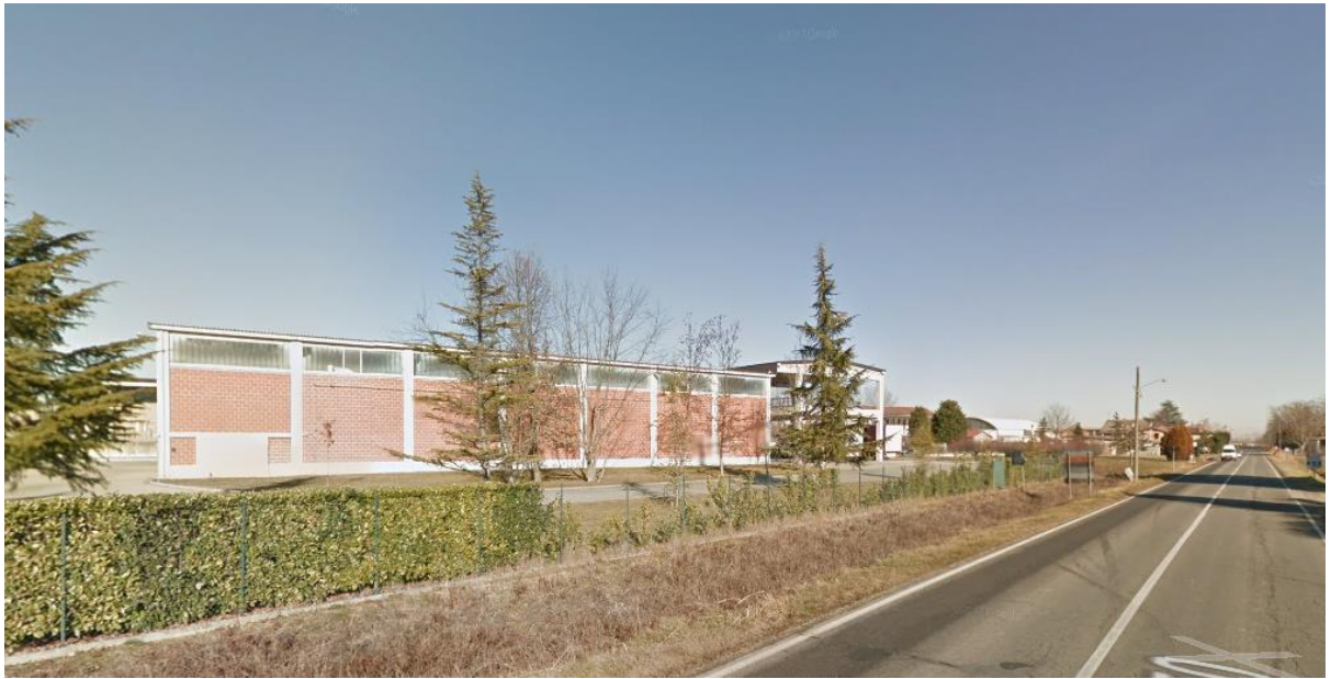
Area industriale lungo la S.P. 50
