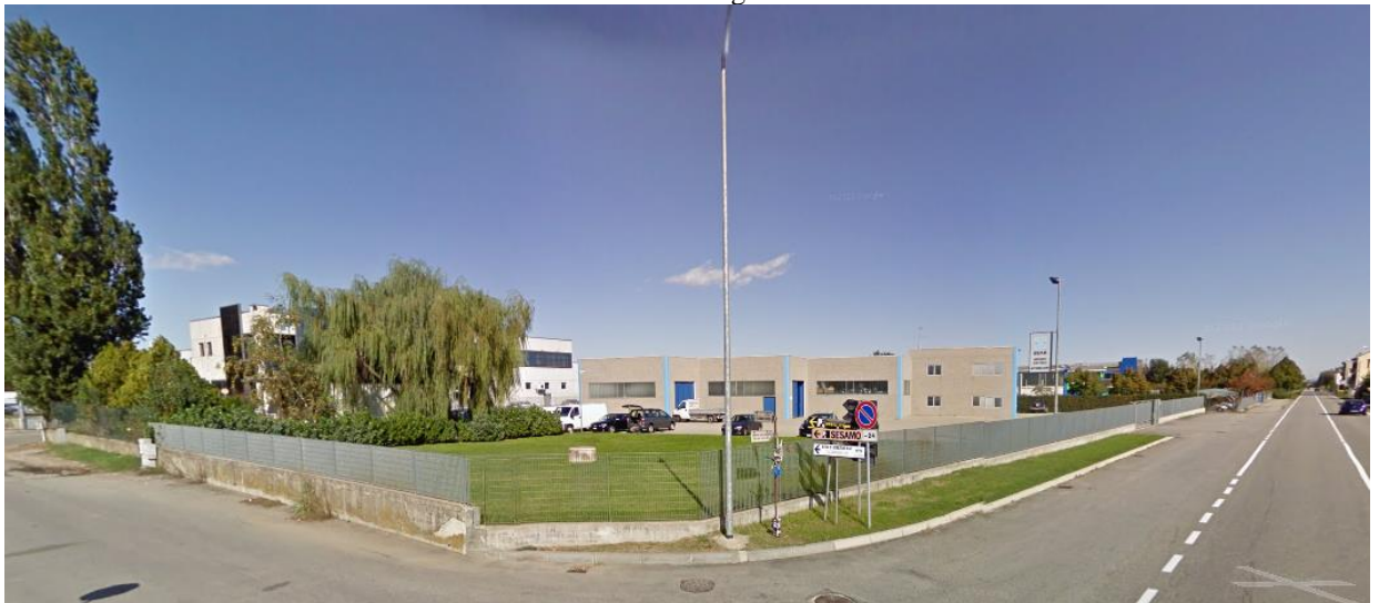
Ingresso area industriale lungo la S.P. 50 verso Casale M.to
